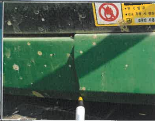
캐빈 하부 커버 파손
