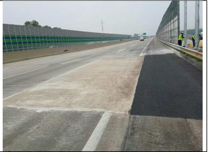
아스팔트 및 콘크리트 도로 포장 완료
