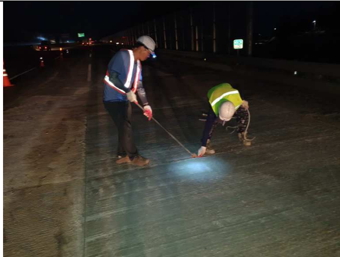
콘크리트 도로 포장 작업 중
