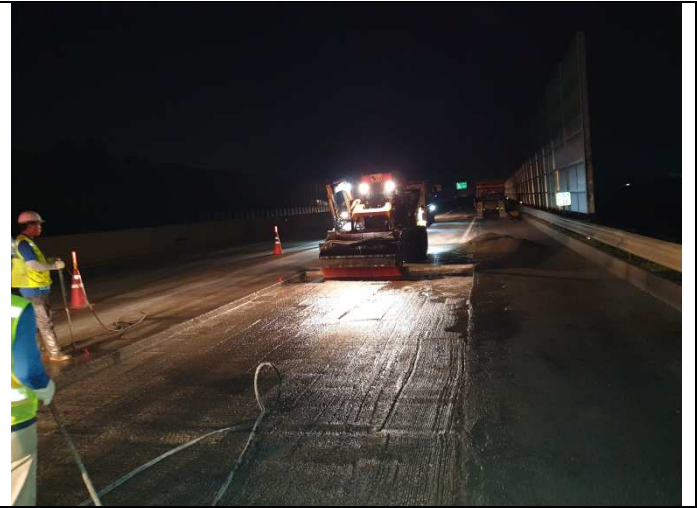
콘크리트 도로 포장 작업 중
