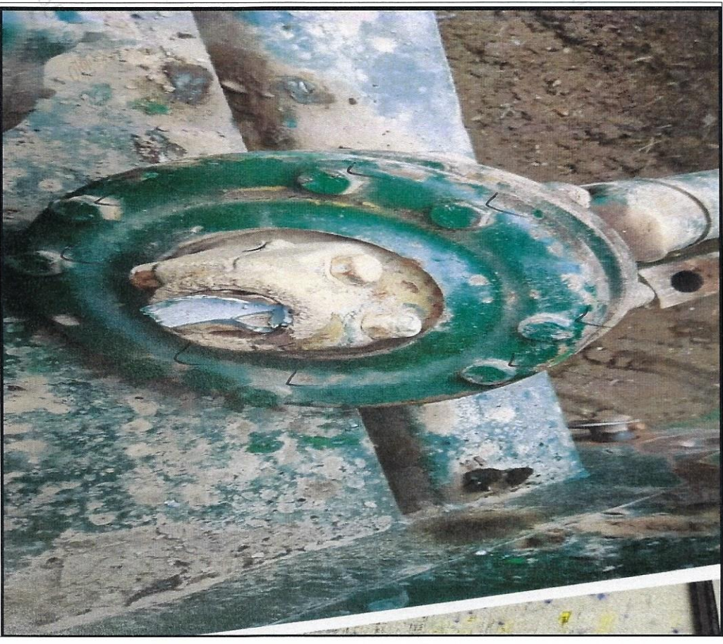
안전장치 해체를 하지 않아 발생한 사고이다. 위 풍치를 보면 볼트가 8개가 있는데 검정색이면 사고이나 위 부품은 안전장치를 해제 하지 않아 발생한 사고로 추정됨 또한 피손단면의 축 받은 허양고 받은 녹슬은 모습을 볼 수 있음
