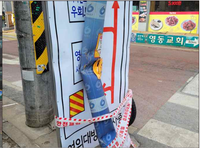
CC-TV Pole 파손상태
