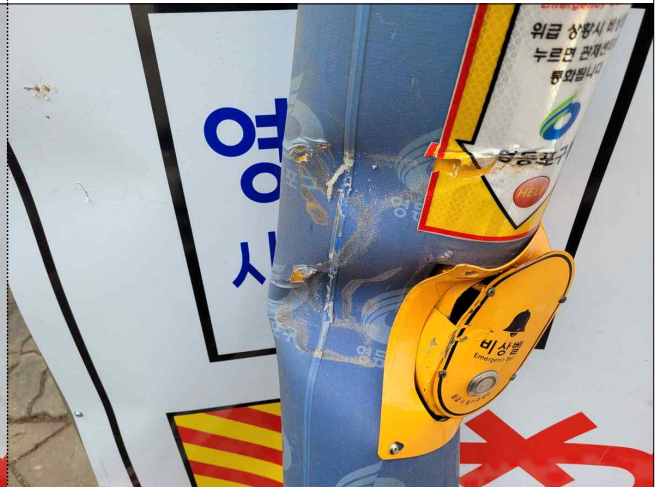
비상벨 세트 + 불법부착물 시트 파손
