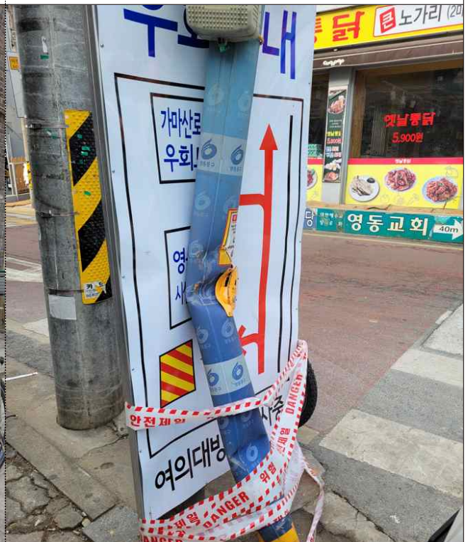
사고 현장 및 Pole 파손상태
